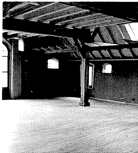
Aanbrengen binnenisolatie. Vergunning nodig
